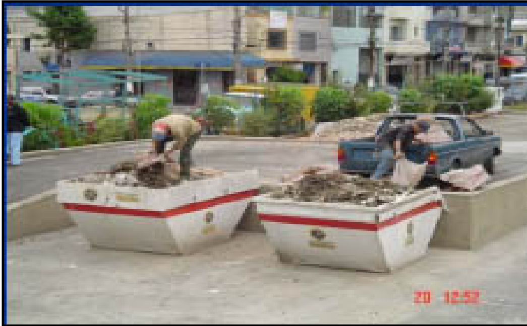
Figura 8.3 - Acondicionamento de Resíduos de obra civil
