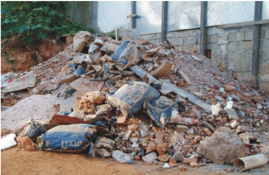
Figura 8.2 - Resíduos de obra civil
